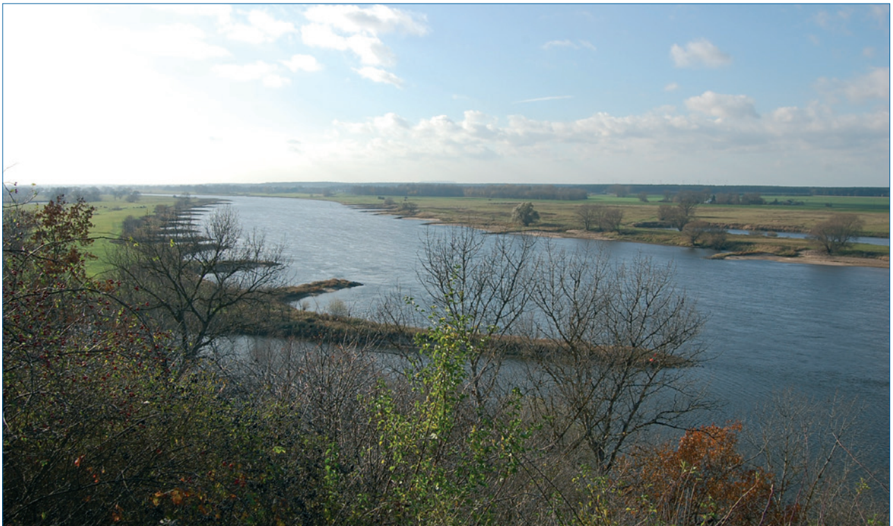
Von Bühnen eingefasste Stromelbe bei Derben. In den Bühnenfeldern am rechten Ufer sind Sandbankbildungen erkennbar. 11.11.2008. Foto: U. Patzak.
